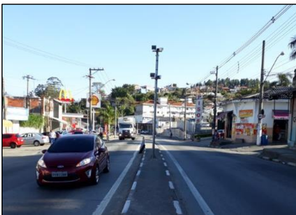
Foto 19 | Vista do viário.
