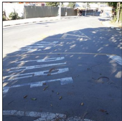
Foto 16 | Pavimentação e sinalização nos acessos secundários do entorno.
