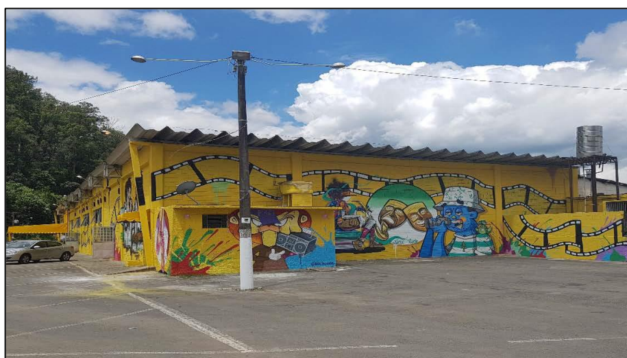
Foto 23 | Centro de Eventos Ícaro Della Torre de Oliveira, no Parque Ecológico de Caieiras – PEC.
