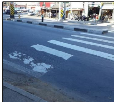
Foto 18 | Vista do viário.
