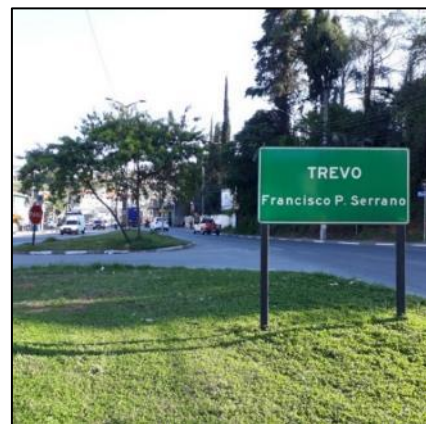
Foto 20 | Vista do viário.
