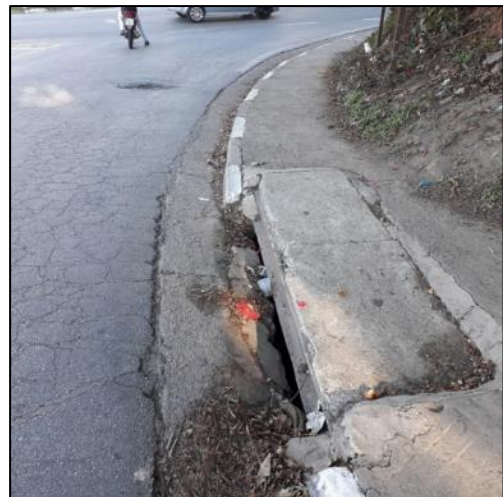
Foto 14 | Sistema de águas pluviais do entorno.
